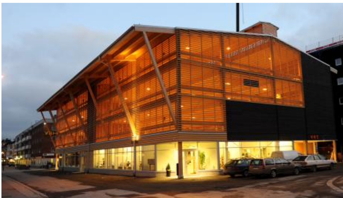
Parkeringsgarage, Skellefteå. (Foto: Robert Granström)
