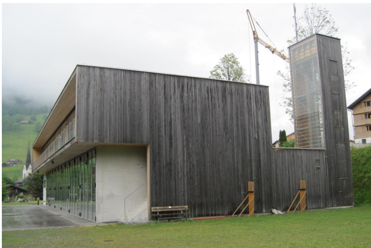
Brandstation, Österrike. (Foto: Trästad)
